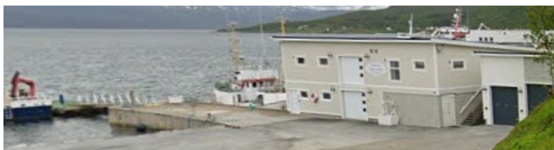
Meyerbrygga med Botnhamn Bygdesamling, Botnhamnveien 793
